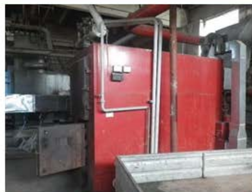
2.5. ATTĒLS: Katlu mājas Viesītes pilsētā, Smilšu ielā 39B šķeldas katls
