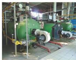
2.6. ATTĒLS: Dabas gāzes katli koģenerācijas stacijā Ozolniekos (pa kreisi) un jaunā šķeldas katlu māja Zemgales ielā 2 (pa labi)
