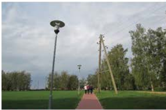
2.29. ATTĒLS: Izbūvēts jauns ielu apgaismojums Variēšu ciemā
