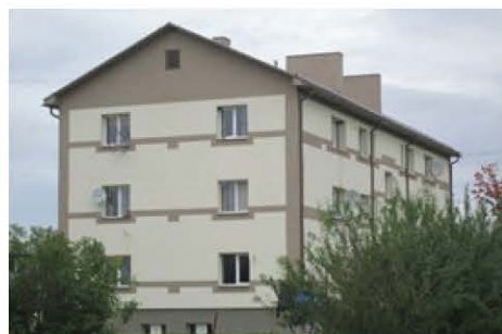
2.22. ATTĒLS: Atjaunota (siltināta) daudzdzīvokļu ēka Kūku ciemā
