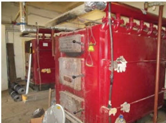
2.9. ATTĒLS: Katlu mājas Brodī, Ābeļu pagastā malkas katls
