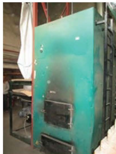
2.13. ATTĒLS: Granulu katls Zasas ciema kultūras namā. Katlu māja nodrošina ar siltumu pavisam 4 pašvaldības ēkas.
