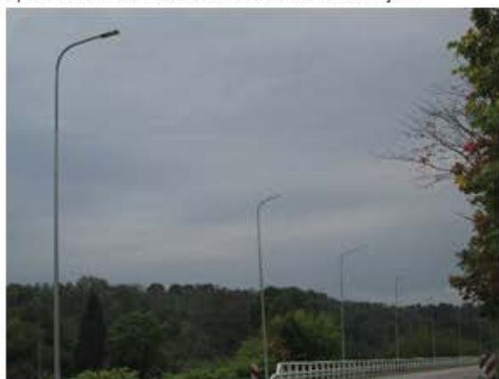
2.17. ATTĒLS: Ielu apgaismojuma rekonstrukcija Jaunjelgavas pilsētā
