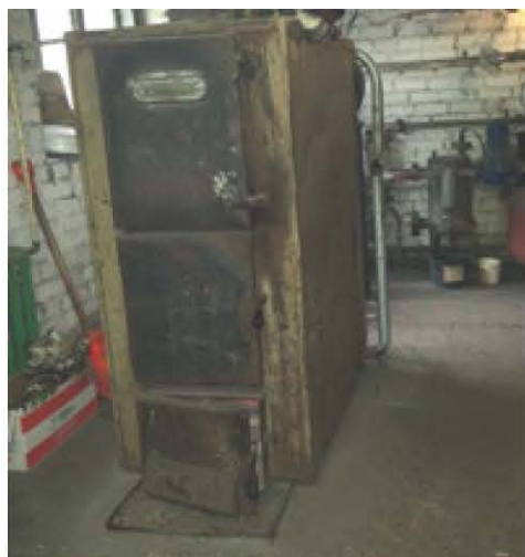
2.8. ATTĒLS: Malkas apkures katls Bēnes vidusskolā augšā, malkas apkures katls PII Vecauce apakšā
