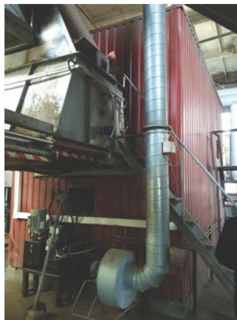
2.6. ATTĒLS: Šķeldas katls katlu mājā Tehnikas ielas 15, Aucē
