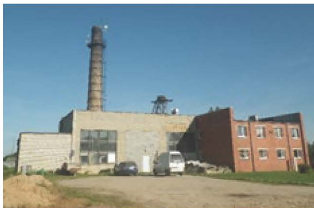
2.6. ATTĒLS: Katlu māja Saltupes ielā 9, Aknīstē
