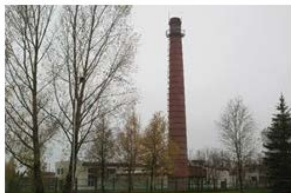
2.7. ATTĒLS: SIA "Aizkraukles siltums" katlu māja Rūpniecības ielā 2
