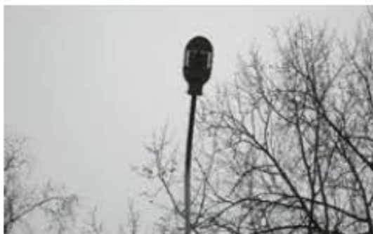
2.24. ATTĒLS: LED gaismekļi Maurēnu ielā, Aizkrauklē (izbūvēti 2013. gadā)
