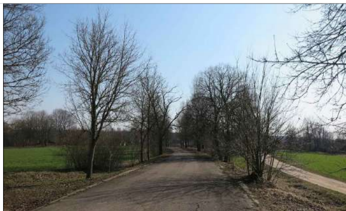
5. Dvaro ansamblio teritorijoje esantis važiuojamosios dalies vaizdas
