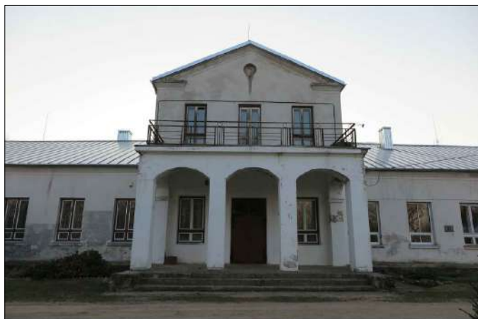
4. Atkurtas dvaro fasadas, po rekonstrukcijos yra šiek tiek supaprastintas
