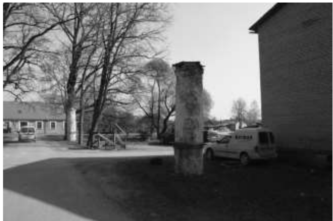
10.att. Zvanu torņa un baložu būra pamatu kolonas (2019.gads)
