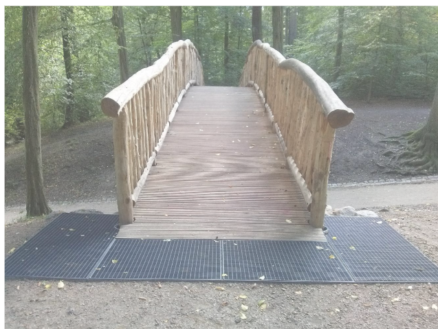
Jenischpark, Vācija. Rekonstruēts parka vēsturiskais tiltiņš - nodrošināta vides pieejamība
