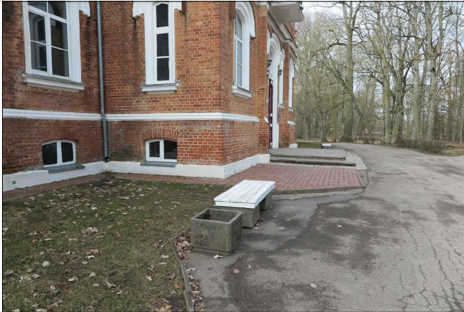
5. Labiekārtojuma elementi Mežmuižas pils ZA pusē
