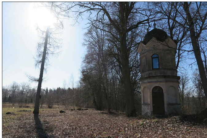
6. Parka paviljons. Tornītim ielikti jauni logi un metāla durvis, lai pasargātu no vandālisma
