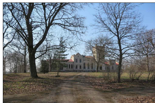
3. Skats no pastaigu celiņa uz muižas pils A fasādi. Atsevišķas koku un krūmu grupas strukturāli saglabājušās labā kvalitātē. Celiņu segums neatbilst vēsturiskai situācijai. Daļēji augstvērtīgs skats.
