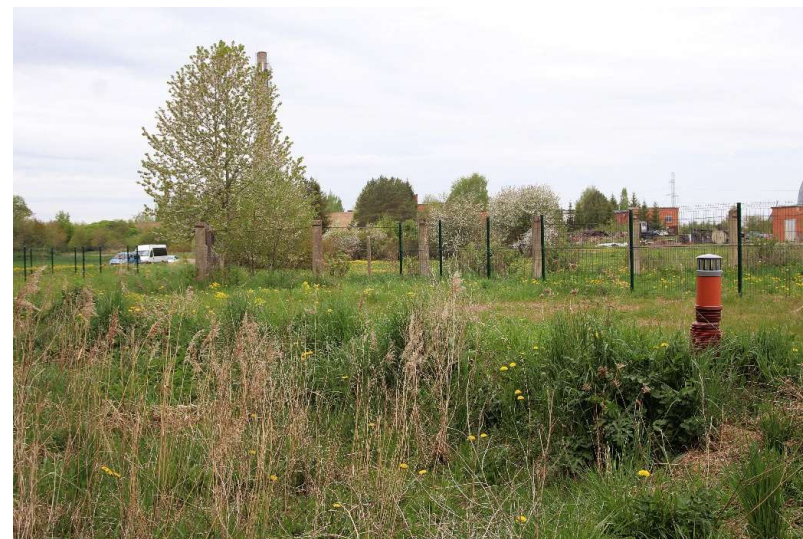
Mākslīgais mitrājs sadzīves notekūdeņu attīrīšanai Jelgavas novada Nākotnes ciemā
